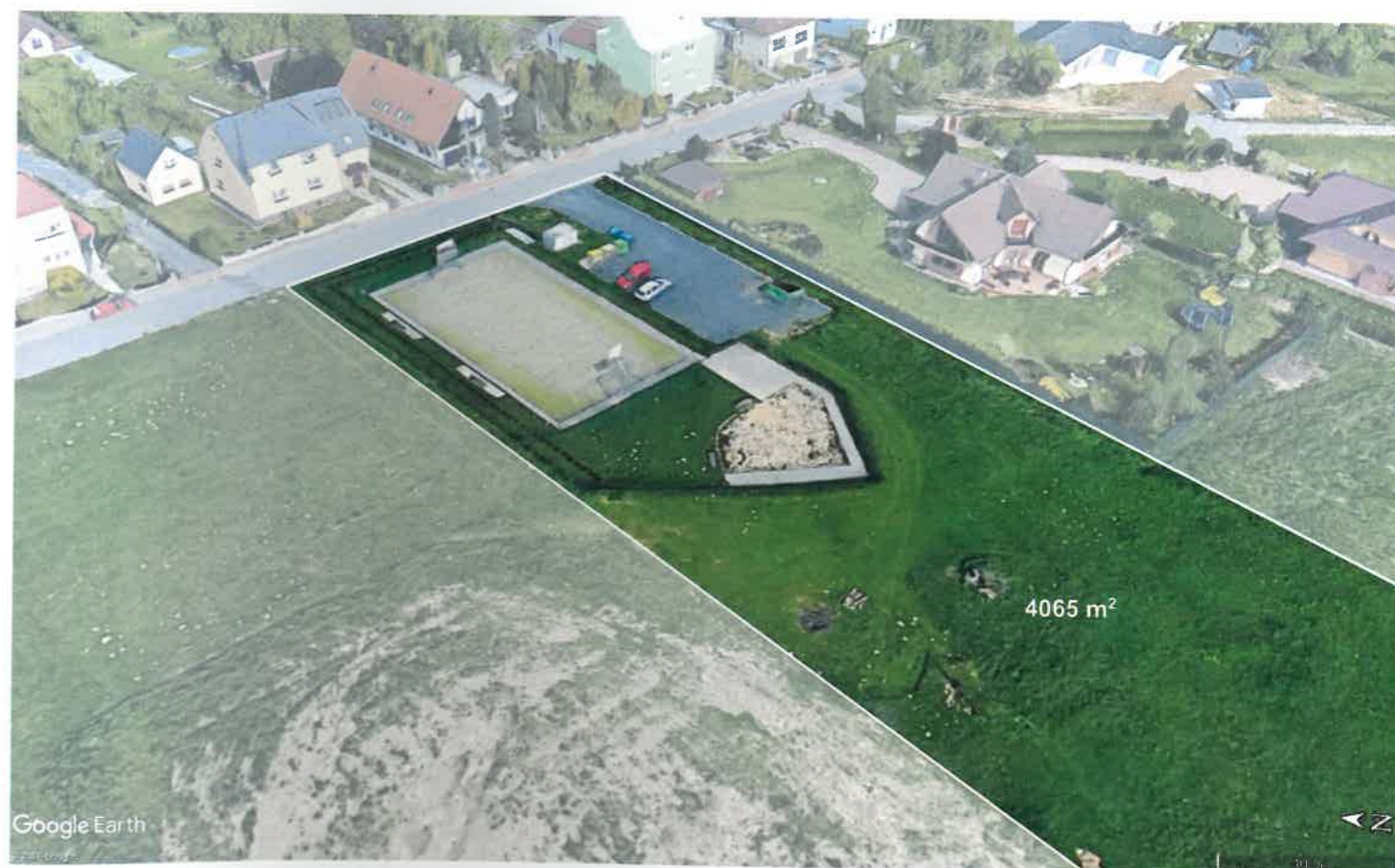
NADHLED ZÁPADNÍ - STÁVAJÍCÍ (ZDROJ: www.google.cz)
