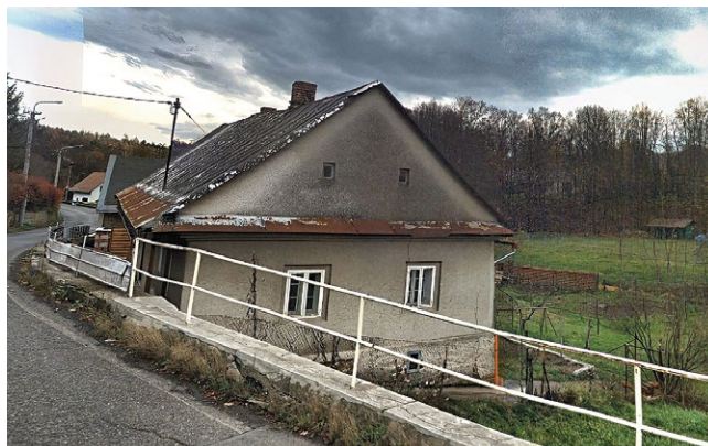
Budova „Staré školy“
